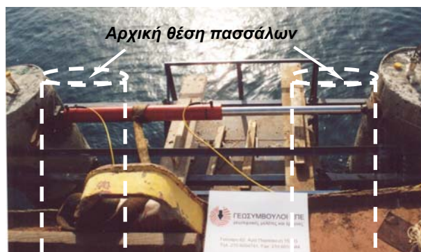
Φωτ. 1. Διάταξη δοκιμαστικής φόρτισης Photo 1. Pile load test layout.
